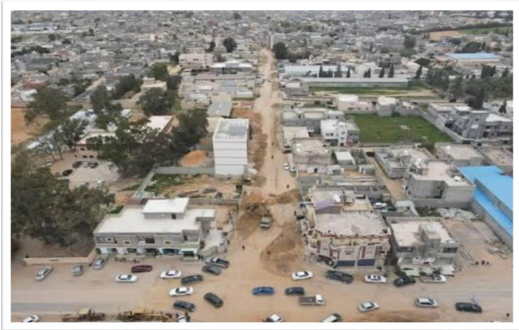
الشكل (5) يوضح عملية توسيع للشوارع
